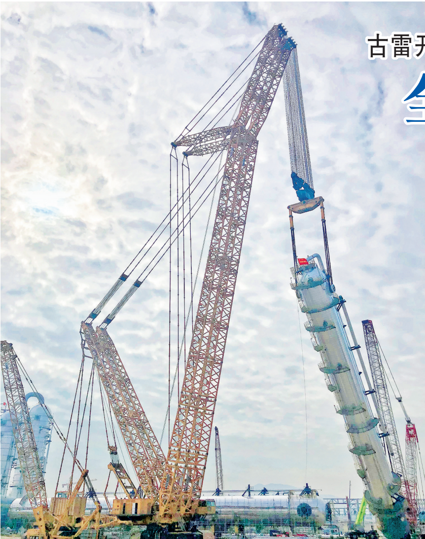
全球最大履带式起重机——4000吨级履带式起重机正吊装设备 游斐洲 摄
