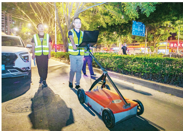
作业人员使用便携式雷达对金峰路东侧非机动车道疑似病害点进行复测
