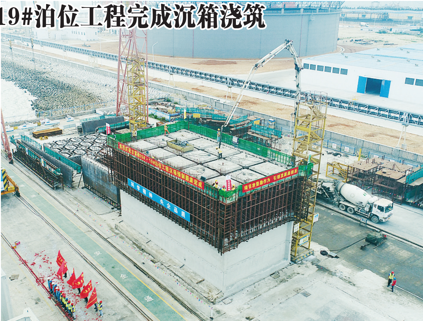
古雷作业区南15#~19#泊位工程浇筑最后一件沉箱
