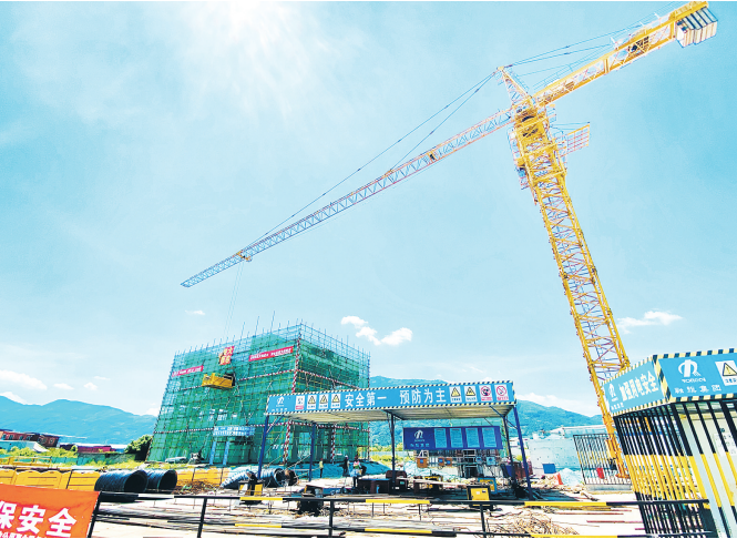
林前污水处理厂项目现场
