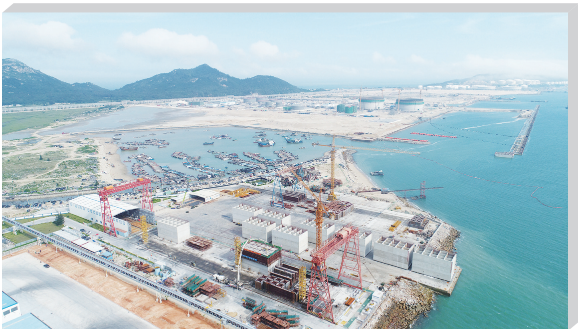
古雷港区南15#1泊位工程圆满完成全部沉箱安装
