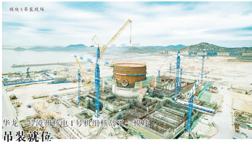
华龙一号漳州核电1号机组核岛又一模块吊装就位
