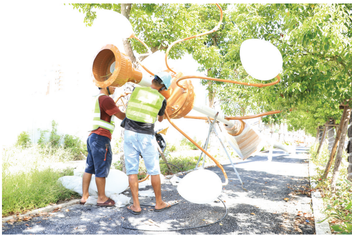
“城市美容师”正在安装路灯
