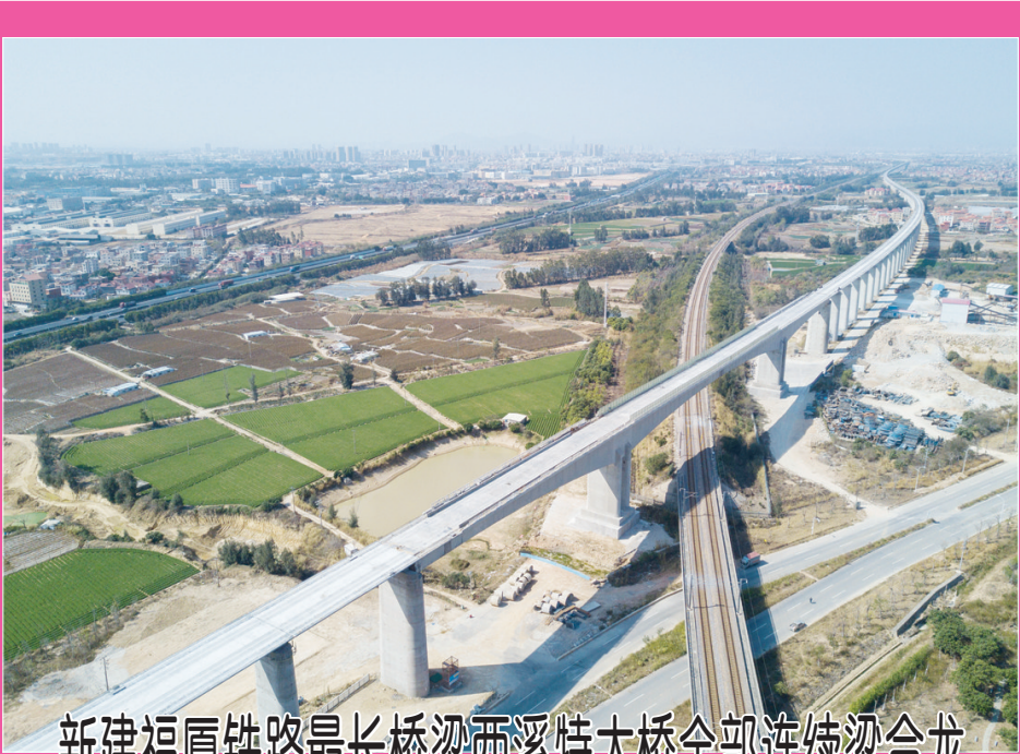
新建福厦铁路最长桥梁西溪特大桥全部连续梁合龙
