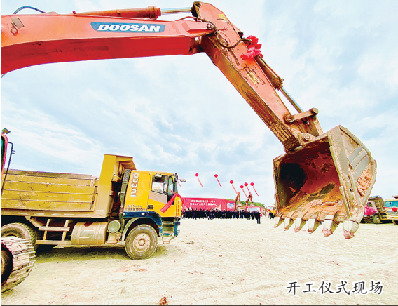
开工仪式现场
