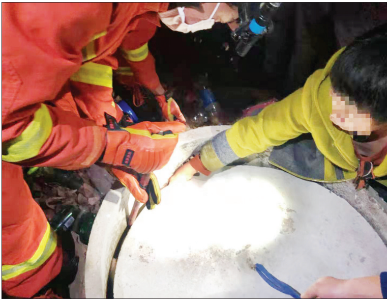
消防人员在对井盖进行破拆
