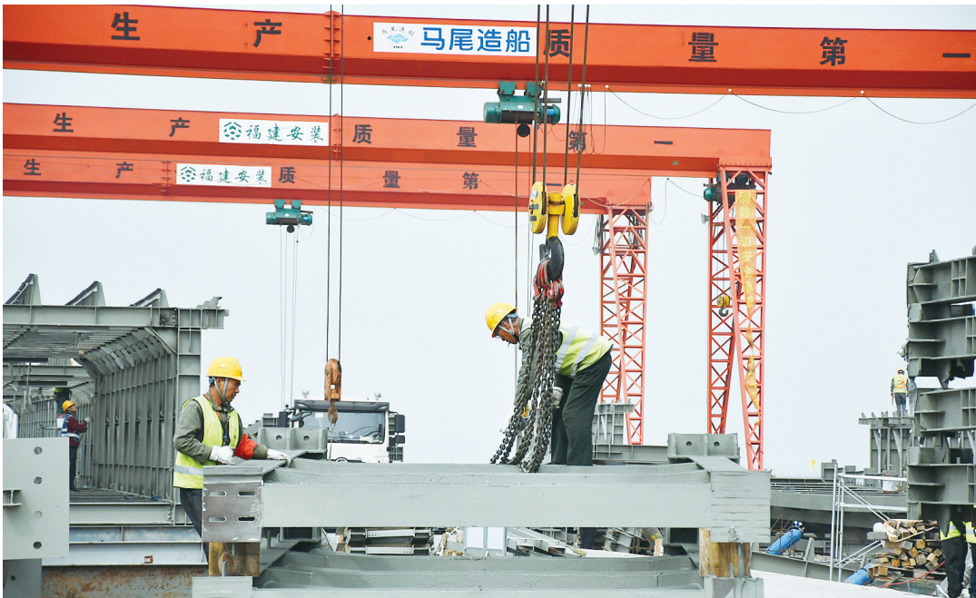
图为电力管廊拼装现场
