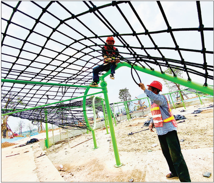
水仙花主题乐园建设中的云端爬网设施
