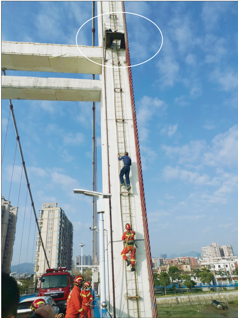
黄建宏(中)和消防员爬上桥塔救人
