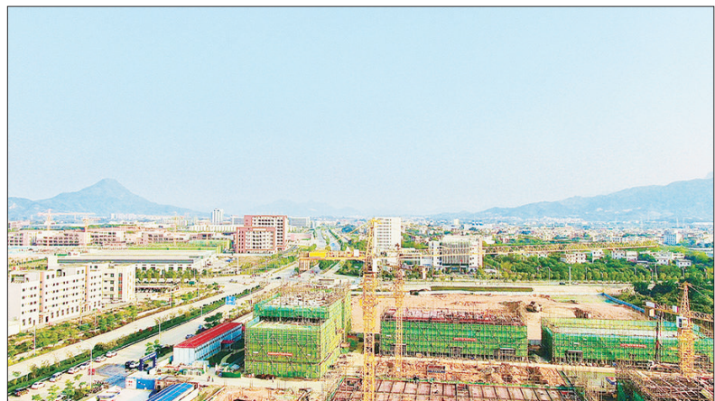
位于漳州高新区靖圆片区的岁金智能装备产业园项目塔吊林立,建设现场如火如荼。
