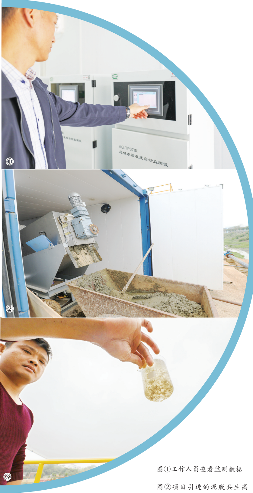
图②项目引进的泥膜共生高效混凝污水净化器可排出污泥
