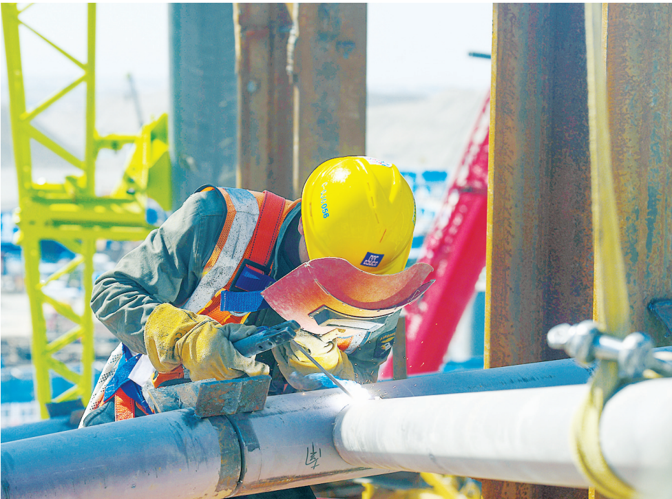
4月16日，在劳动技能竞赛现场，来自中建三局的施工人员刘政参加焊接技能比武。 新华社发
