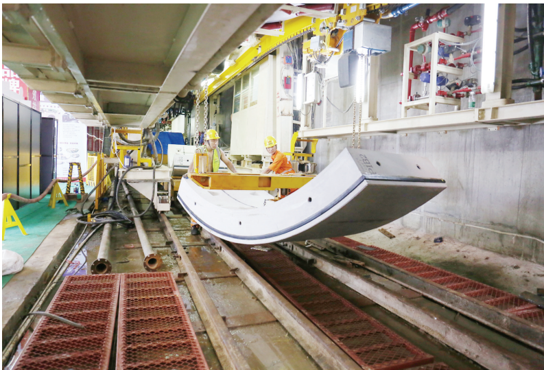
工人将成型预制管片拼装上盾构机 杨奕 摄
