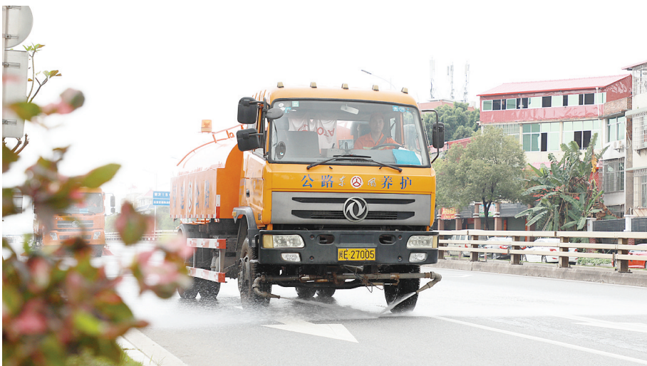
公路养护车在进行洒水养护作业
