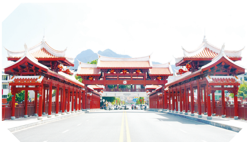
▲2019年,南靖县城中山廊桥正式通车,对改善居民出行条件和生活环境具有重要意义。张梦帆 摄
