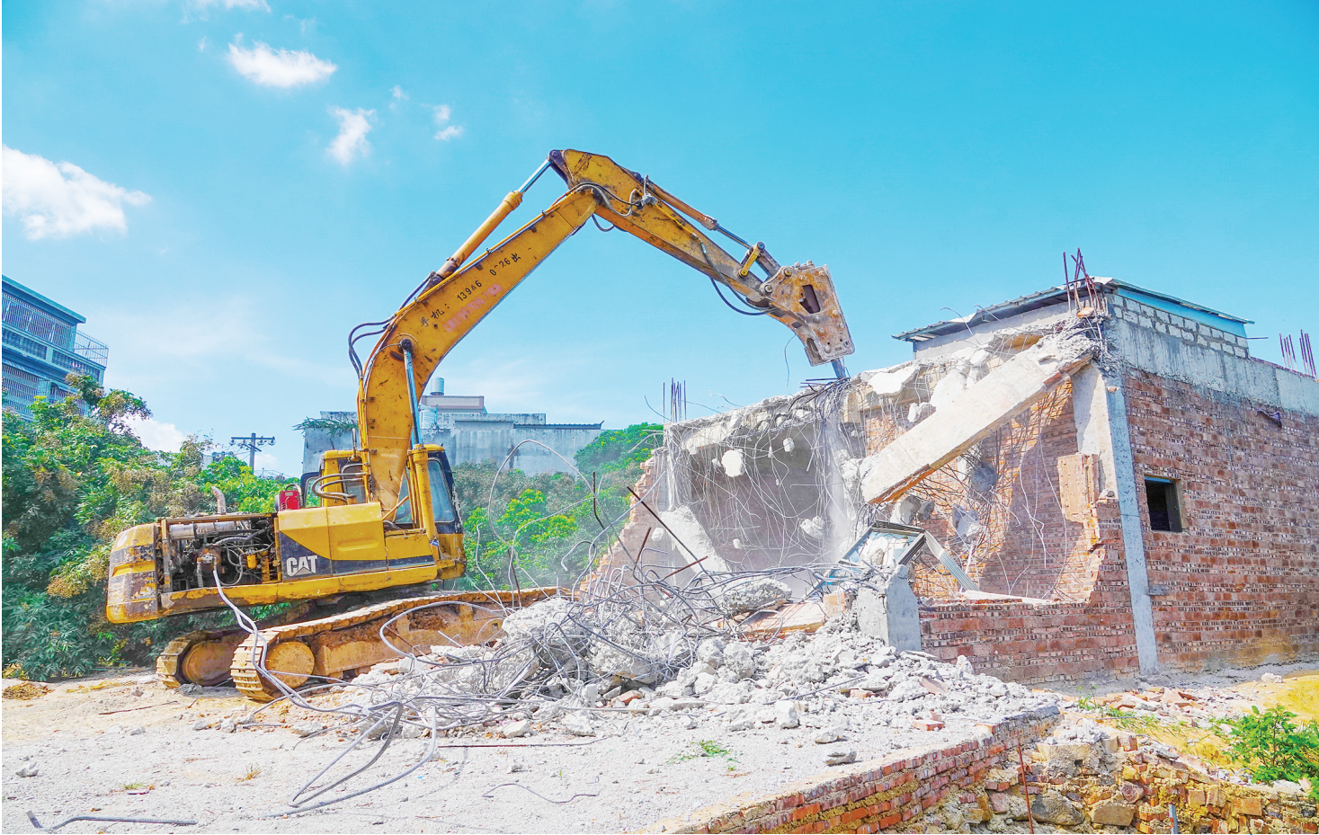
近日,在诏安西潭镇后陈村的耕地建房整治现场,挖掘机轰鸣,现场正对一宗一层占地约90平方米的框架结构建筑进行拆除作业。连日来,诏安县有关单位部门密切联动协作,迅速组建新增乱占耕地建房整治、专项工作督查、巡查队伍等,有条不紊地推动工作开展,目前新增的58宗违建房已拆除52宗,拆除率超过89%。 郑斯楠 文 陈逸帆 图
