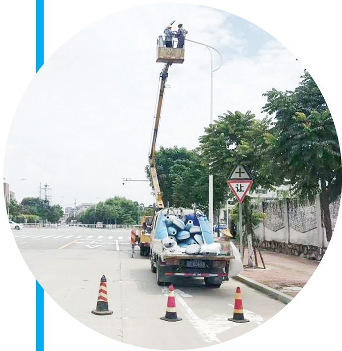
对存在问题的灯具进行更换
