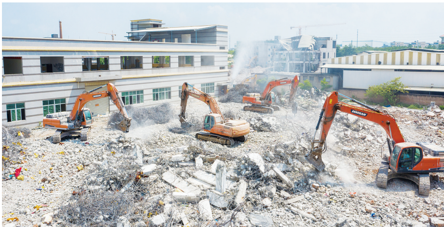
蓝田经济开发区新社片区(一期)拆迁现场
