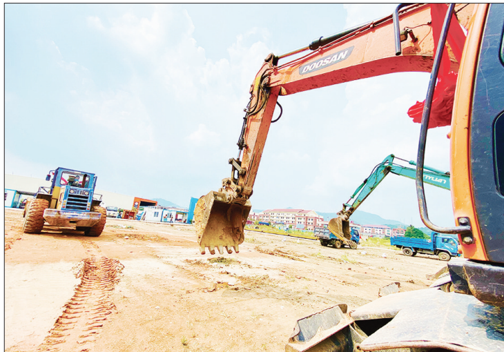
美山现代物流城项目建设现场
