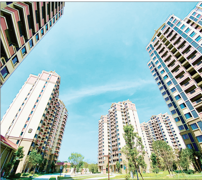
廊前棚户区改造项目已经竣工,有望10月份交付使用。
