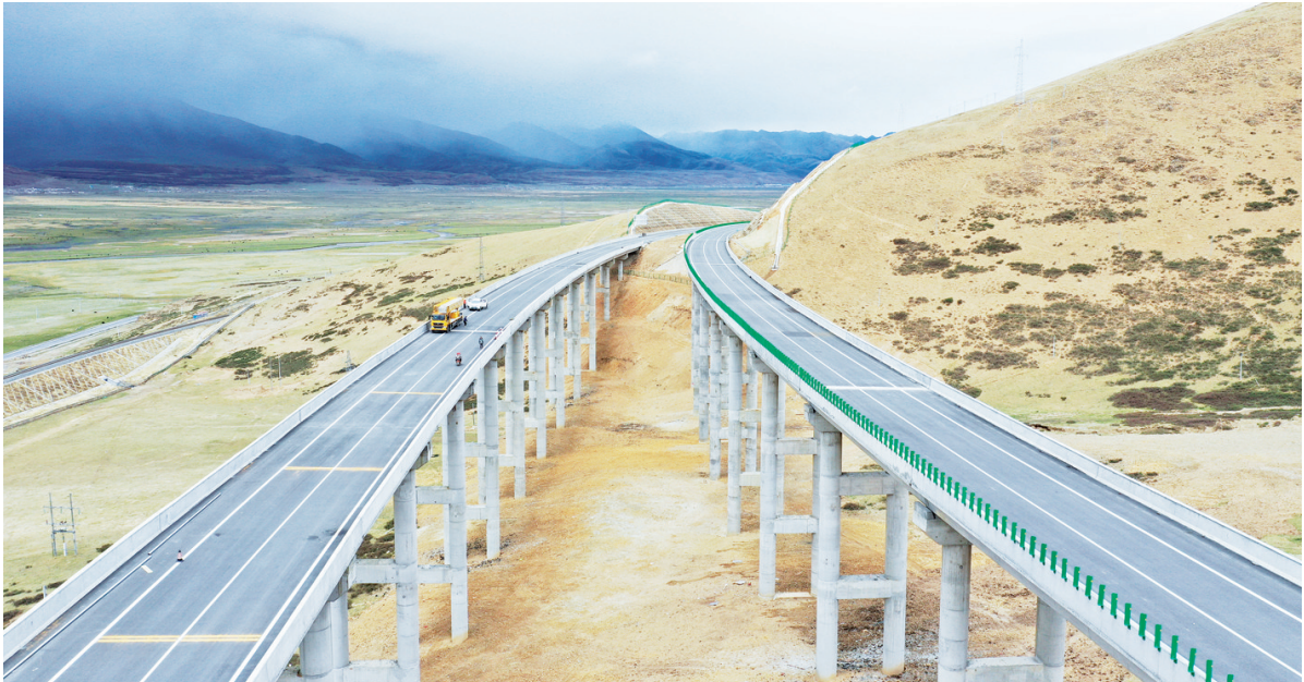
西藏拉萨市当雄县境内由中铁城投承建的京藏高速那曲至羊八井段堆巴果大桥(5月29日摄,无人机照片)。
