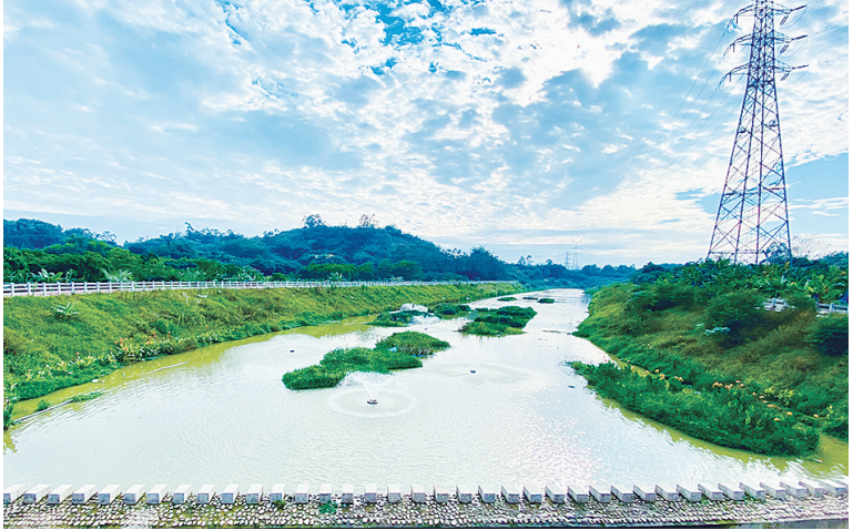
高新区武林渠表面曝气作业现场
