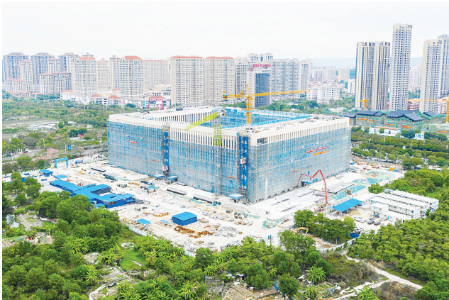
在建的漳州市行政服务中心新大楼 本报记者 陈逸帆 摄
