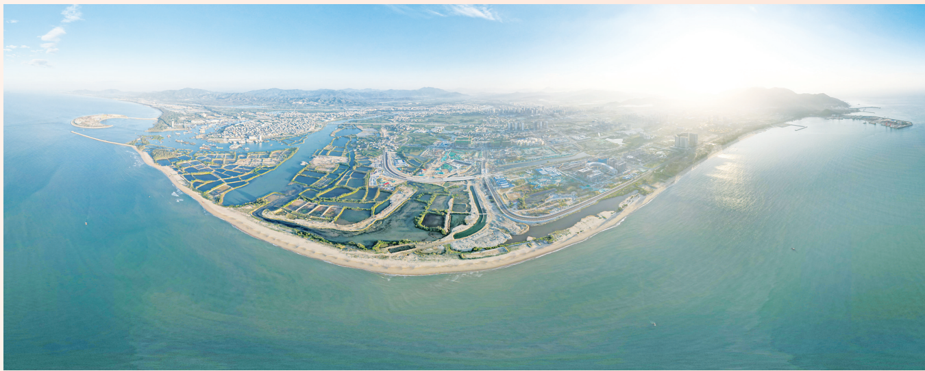
这是1月6日拍摄的正在建设中的崖州湾科技城,海南自贸港建设项目2022年度第一批集中开工仪式在此举行(无人机照片)。
