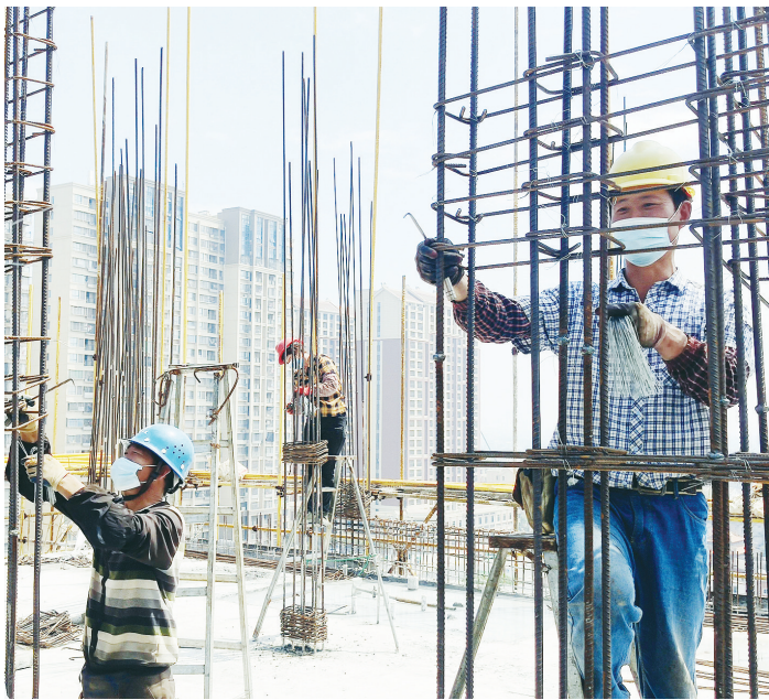
3月30日,龙海区榜山镇后港棚户区改造安置房二期项目建设正如火如荼进行。 黄晓明 摄
