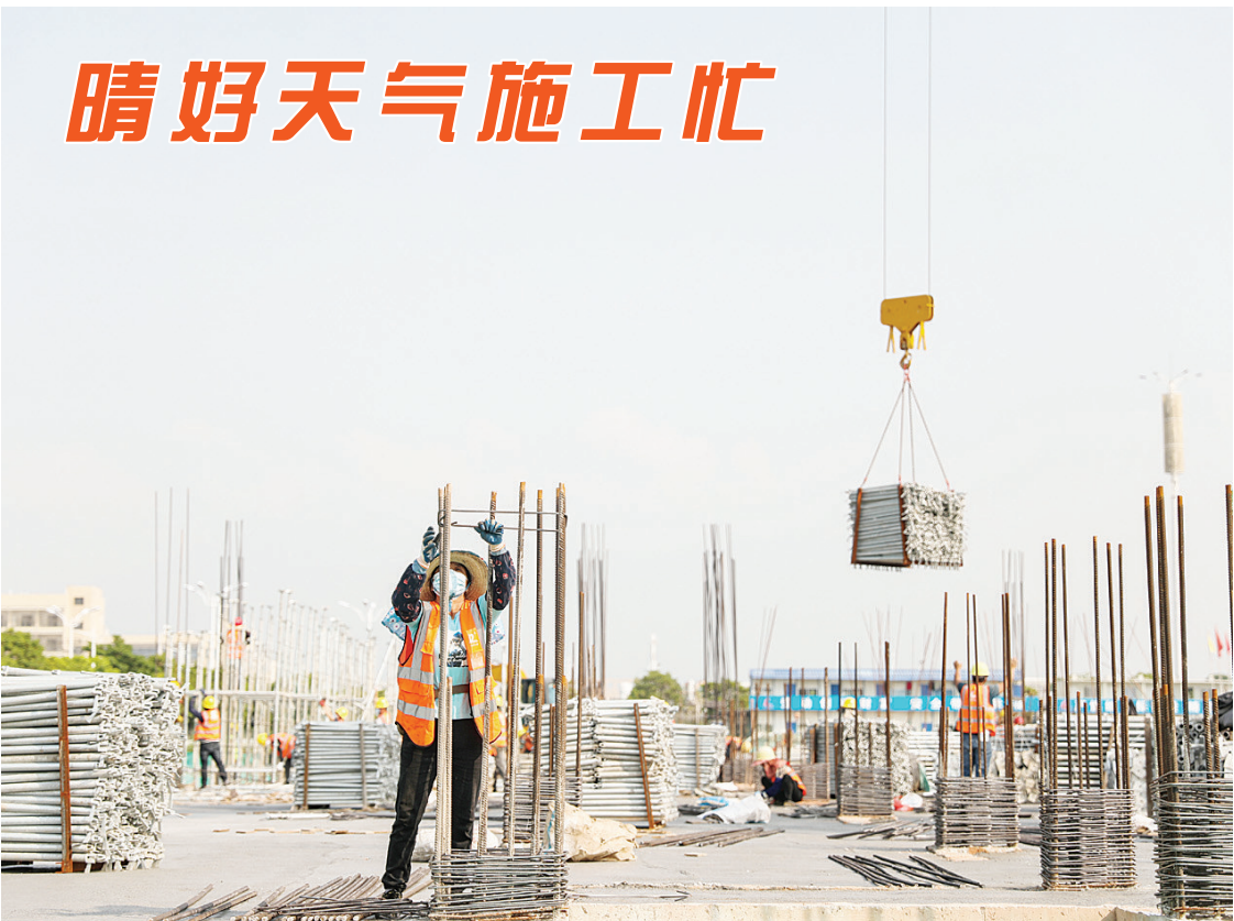
连日来,在芗城区金峰经济开发区做农生物科技产业园项目建设现场,工人趁着晴好天气抓紧施工,现场一派忙碌景象。该项目用地面积129亩,总投资5.3亿元,建设主体包含生产车间、研发大楼、生物诊断试剂生产线、原料库、成品库和系列附属、生产配套用房。
