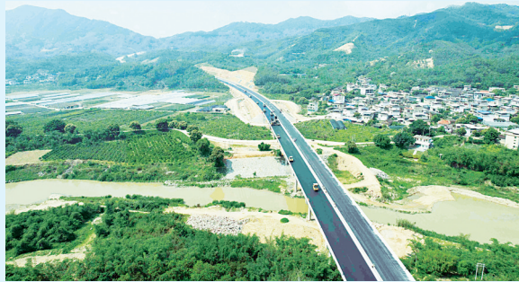
在南靖县道马山线的施工现场,工人们放弃“五一”假期,抓紧施工,加快项目建设。 余祥龙 摄
