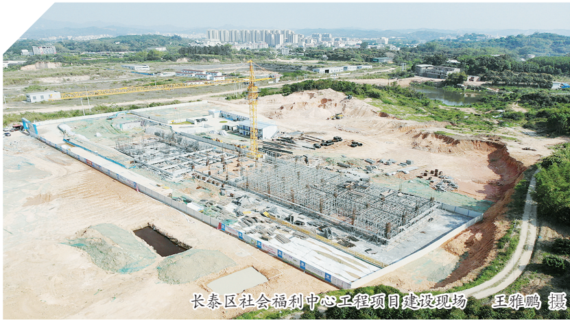
长泰区社会福利中心工程项目建设现场 王雅鹏 摄
