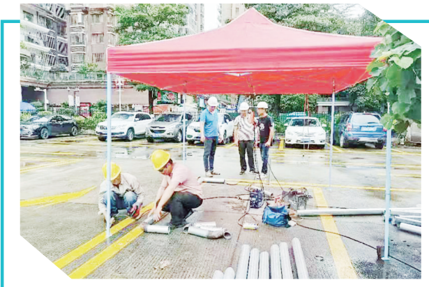
施工人员用移动式帐篷克服暴雨影响不间断作业
