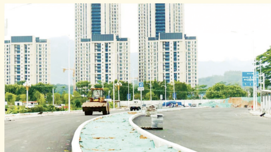
漳浦县金鹿路道路改造工程A段正在扫尾施工
