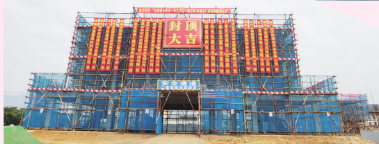
城乡供水一体化项目一期工程岩溪水厂综合楼顺利封顶 区水利局 供图
