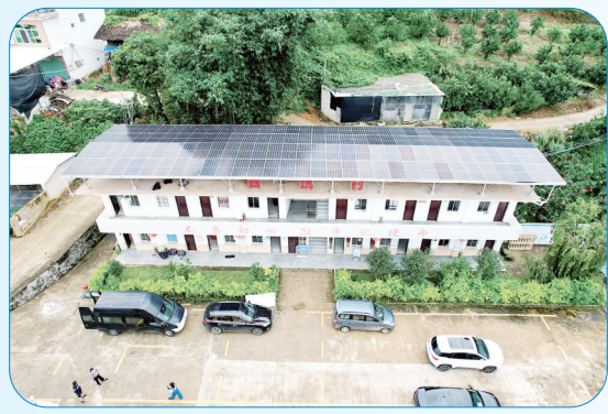
西坑村村委会楼顶光伏发电项目 林泽霖 摄
