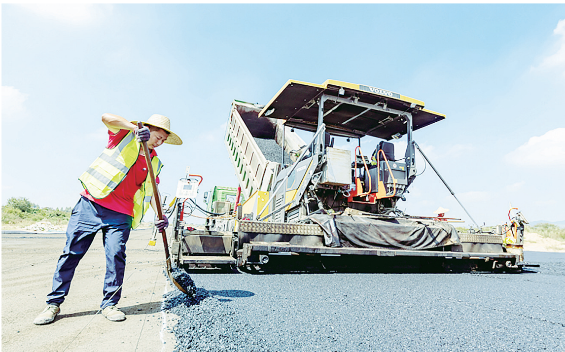
10月2日,在漳浦县万安生态产业园区,施工工人抢抓假期晴好天气,操控大型机械浇筑沥青路面,推进园区基础设施建设。 林杜鸿 摄
