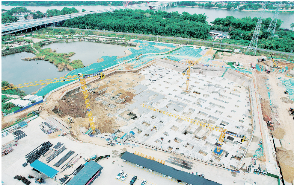
漳龙集团总部经济大楼B、C、D区土方开挖已完成
