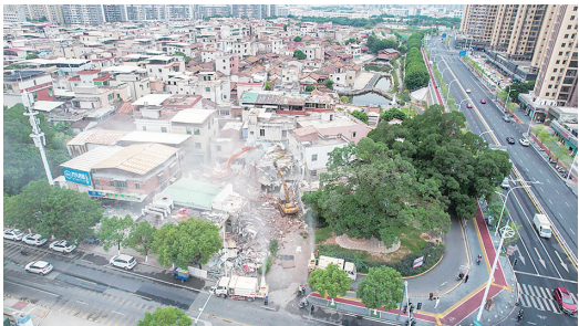
梧桥古厝文创项目征迁拆除现场
