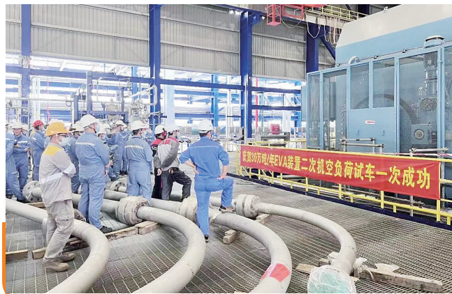
11月18日,古雷石化EVA装置二次机空负荷试车成功。至此,该装置三大核心机组试车工作全面铺开,向全系统投料试车迈进。
