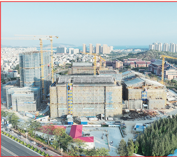
福建谷文昌干部学院二期工程现场
