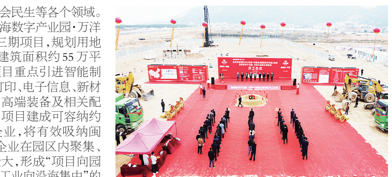
龙海区2023年第一季度重点项目集中开竣工活动
