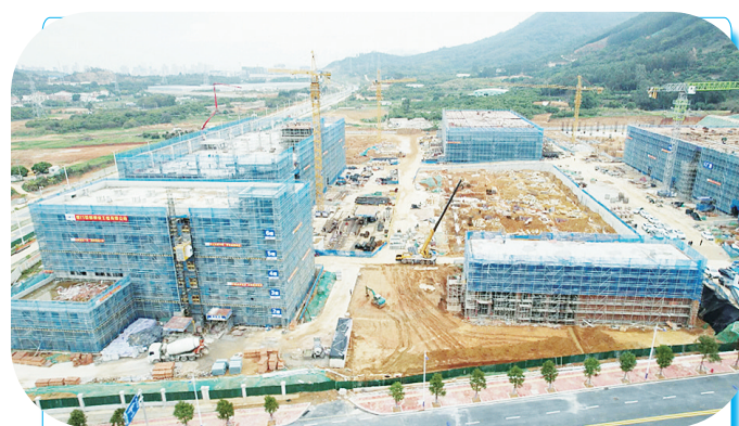
惠尔康生物科技项目建设现场
