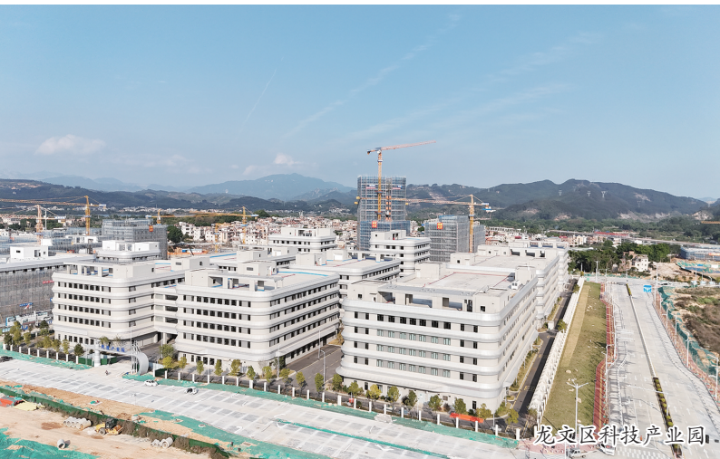
龙文区科技产业园
