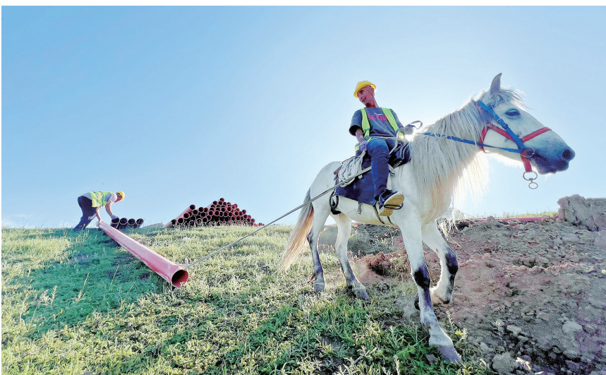
由漳州全额投建的木垒电力管网项目正在进行管道铺设作业
