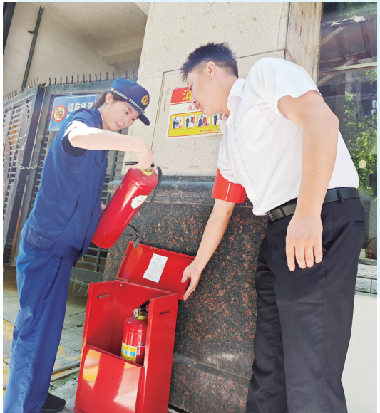
“骏邻”巡查队每周三定期巡查。图为消防队员正在检查消防器材
