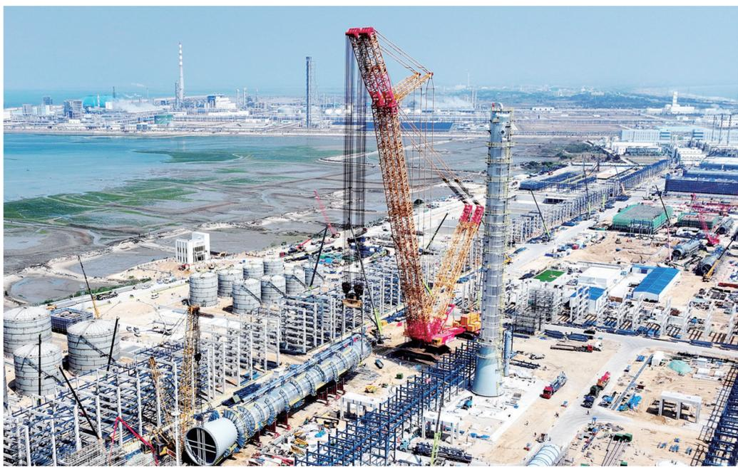
徐工XGC88000型1号机在中沙古雷乙烯项目现场吊装塔器 柯少如 摄
