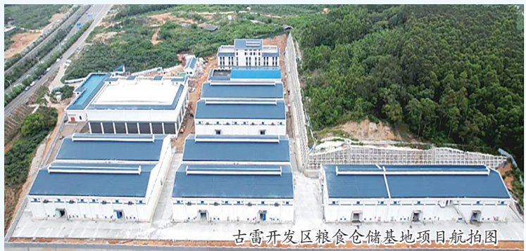
古雷开发区粮食仓储基地项目航拍图
