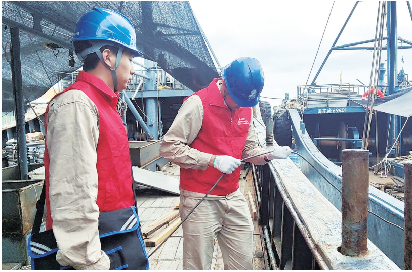
国网漳州供电公司的共产党员服务队在渔港检查线路 郑松清 摄
