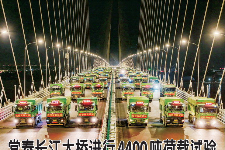
常泰长江大桥进行4400吨荷载试验
