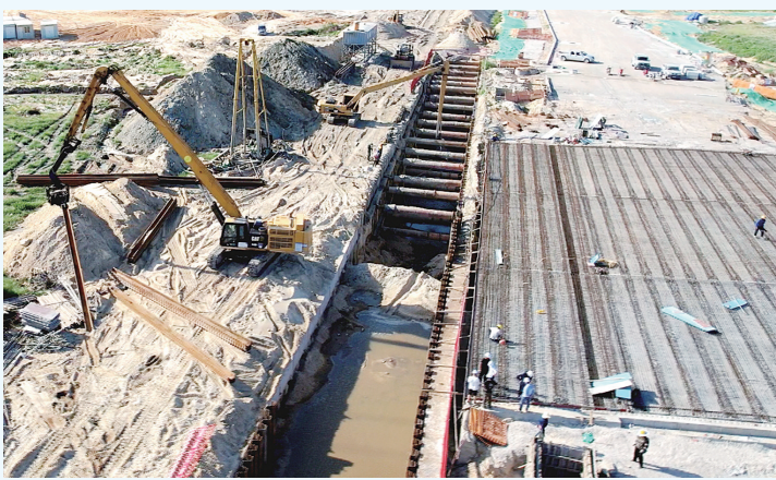
电力管廊第Ⅳ标段工程进入冲刺阶段
